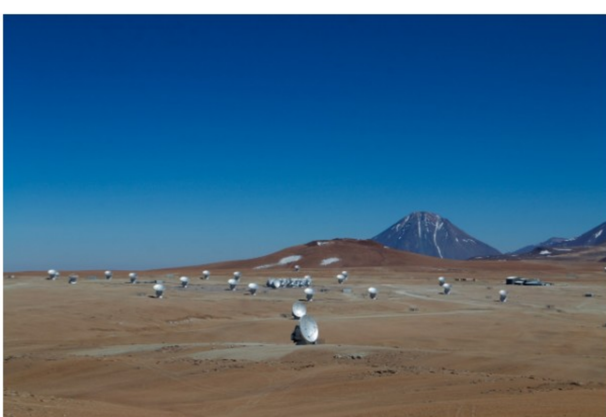
图1，海拔5000米的ALMA阵列和控制室，周边的银白色镜面是ALMA阵列中的12米口径望远镜，正中间比较密集阵列是由7米口径望远镜组成的子阵列，右侧建筑物是控制室。图片提供：自行
