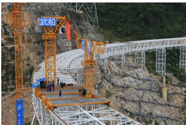
反射面单元空中转接
