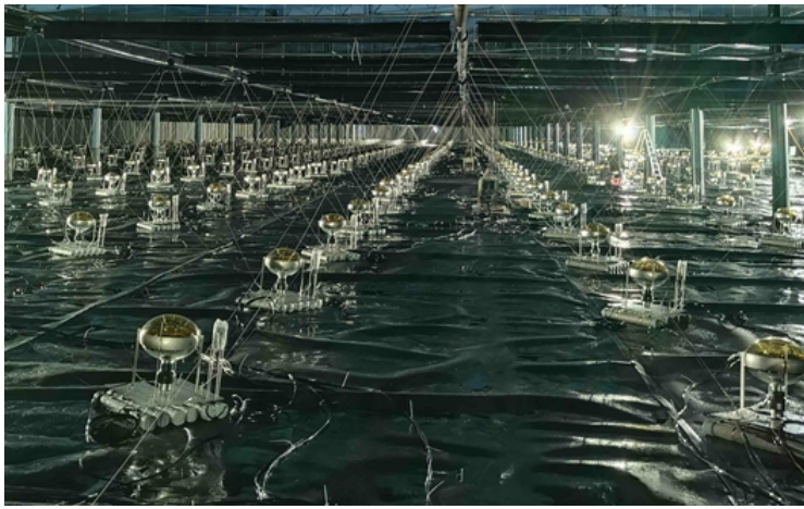
WCDA水池内安装到位的部分探测器阵列（摄于2020年7月16日）（中科院高能物理所供图）
