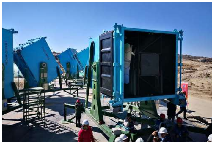
WFCTA工程建设现场
