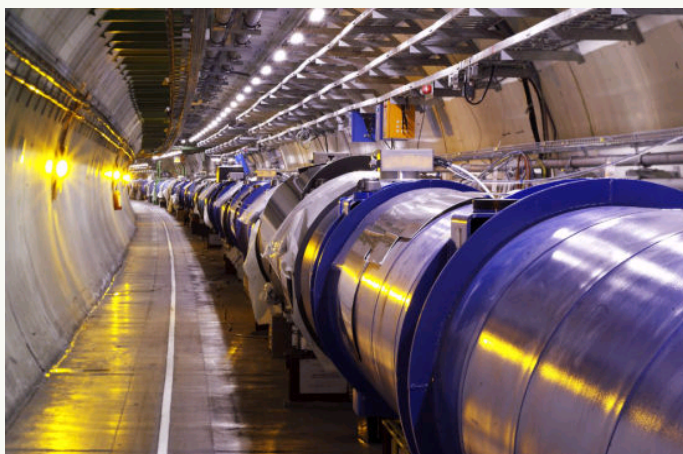
大型强子对撞机地下环形隧道。
