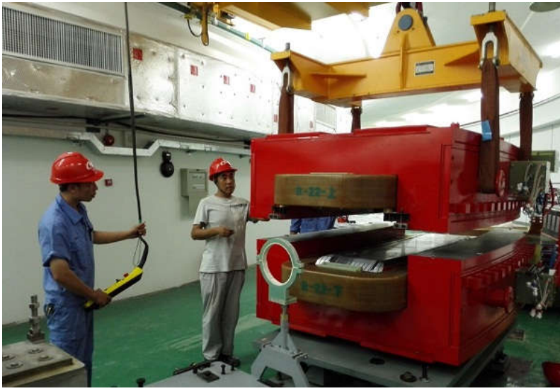
RCS磁铁安装中
