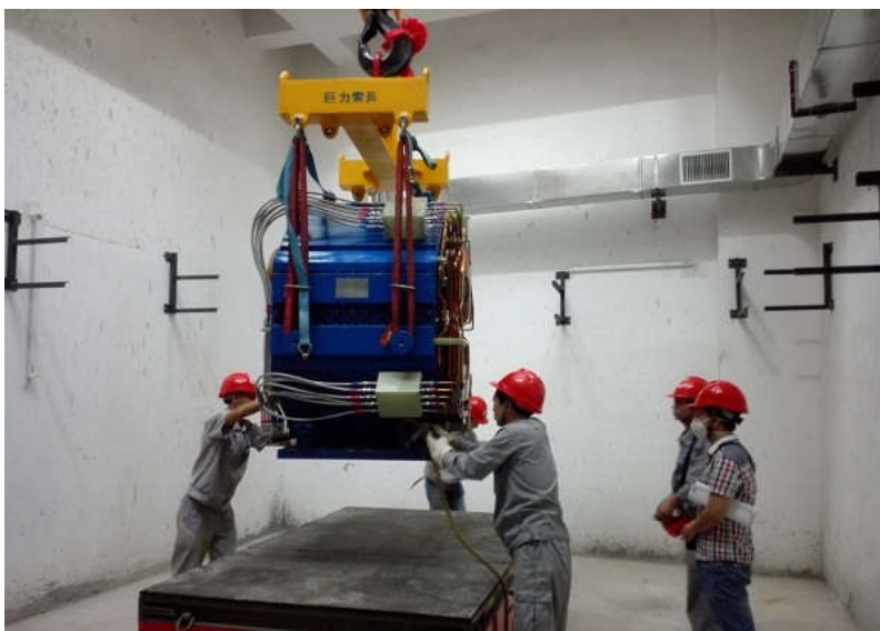
技术人员进行RCS磁铁安装
