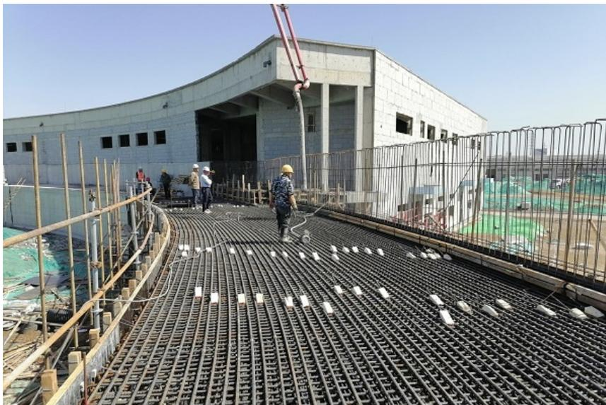
增强器隧道最后一段顶板浇筑混凝土
