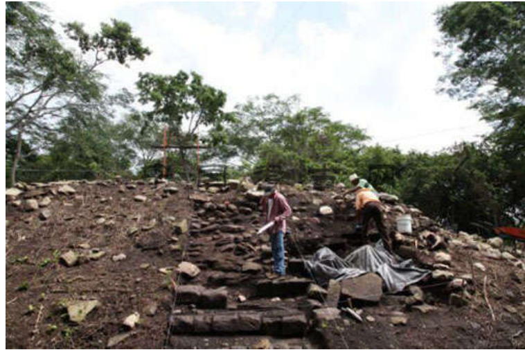
建筑南侧台阶
