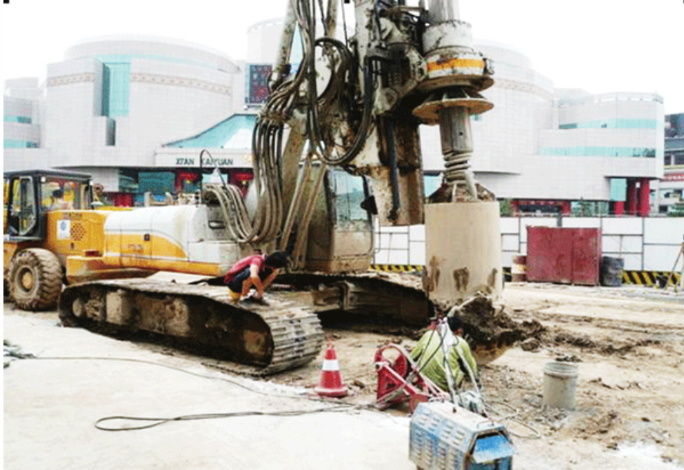
钟楼隔离桩钻孔与灌注现场
