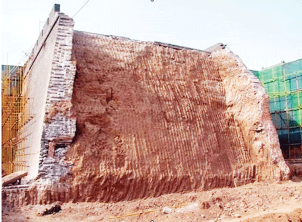
含光门附近开挖揭示的城墙
