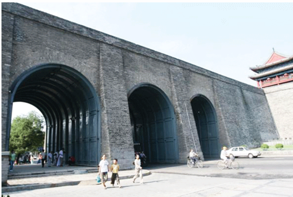
已加固完成的城门洞
