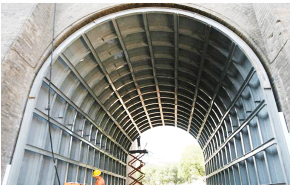
加固城门洞拱型护架
