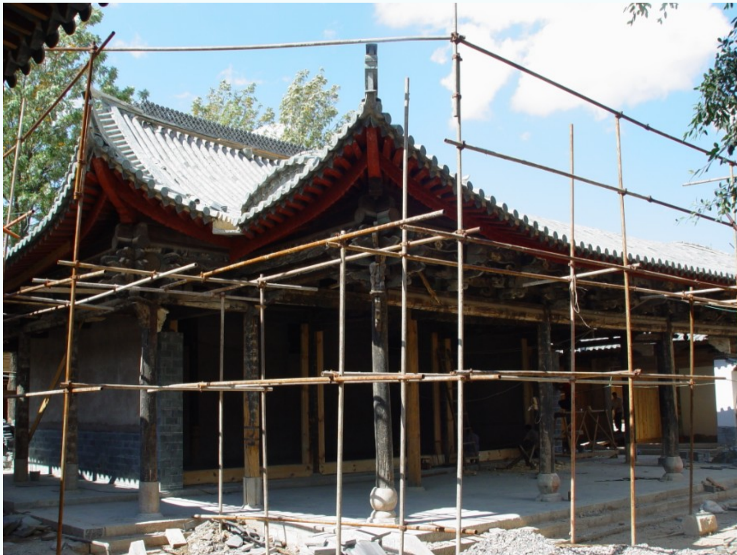
维修施工中的建水学政考棚天君庙大殿
