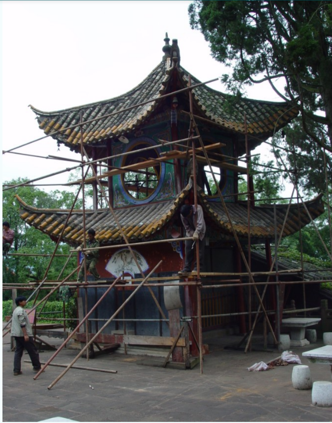
对钟鼓楼进行搭架勘察
