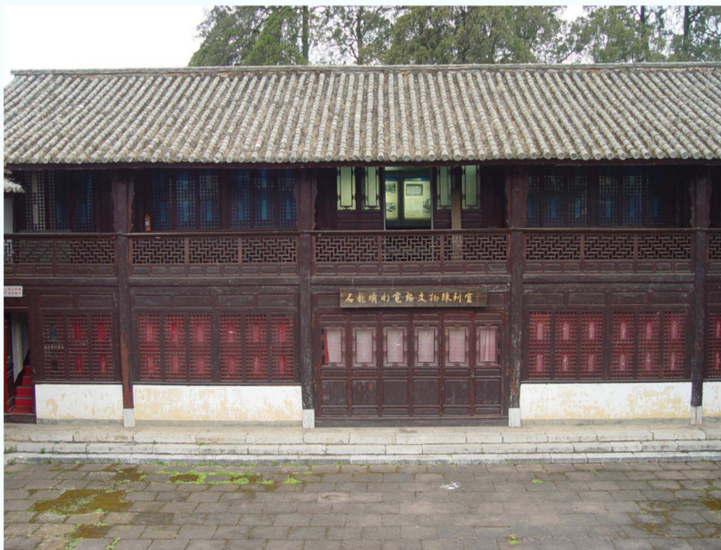
办公楼正房正立面
