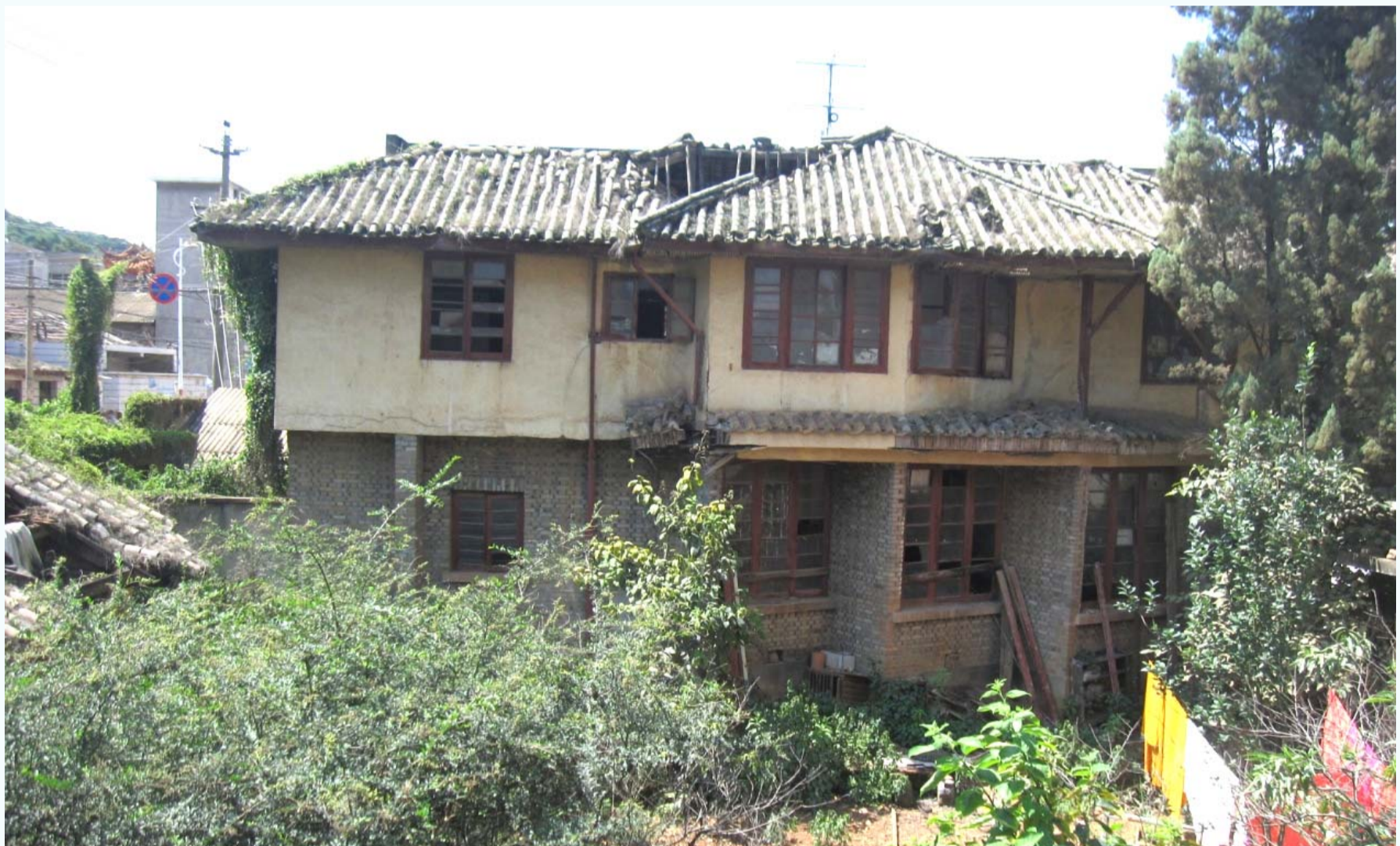
佟家大院主楼南侧
