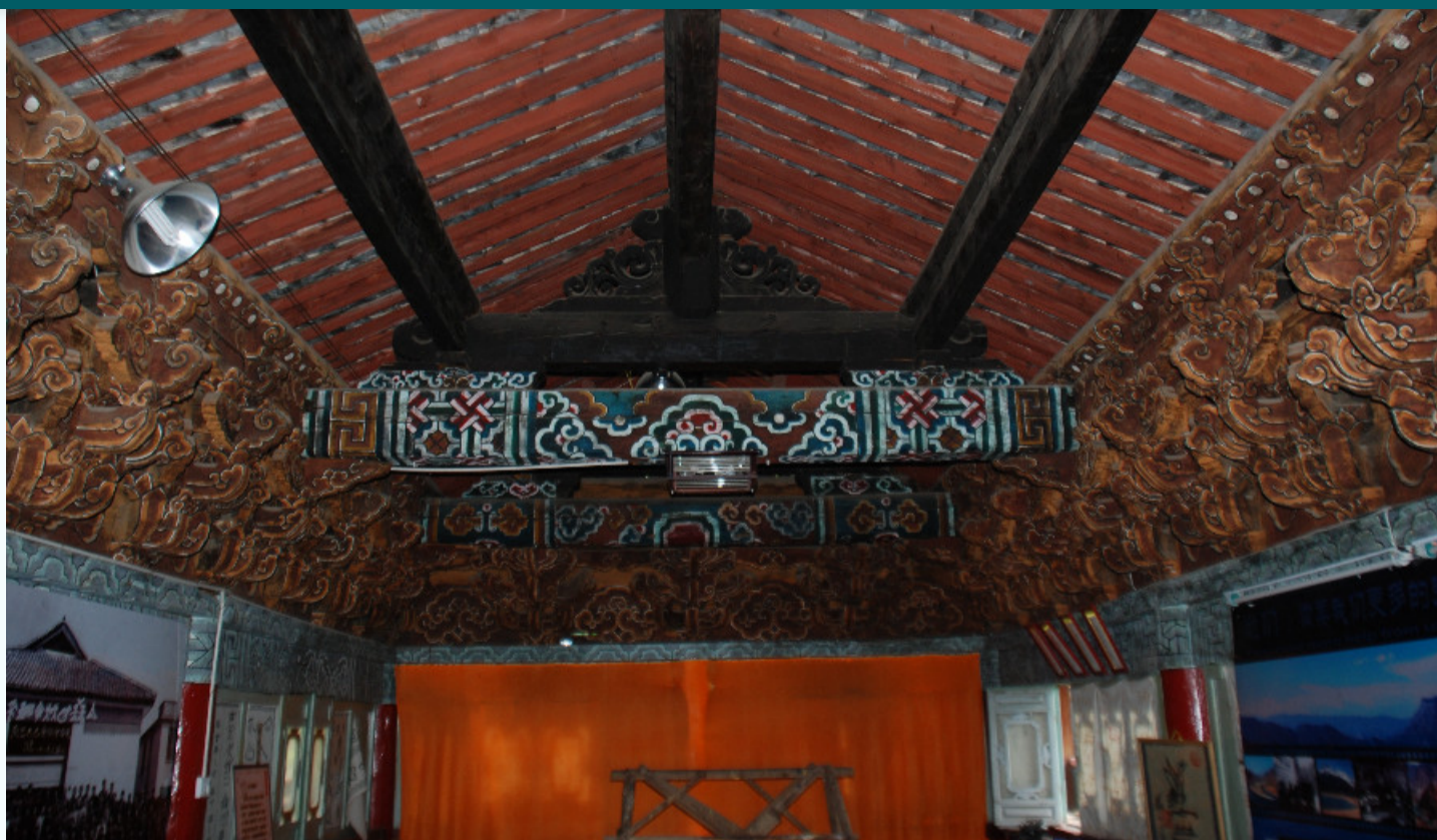
关碧楼室内斗拱、彩画及梁架构造
