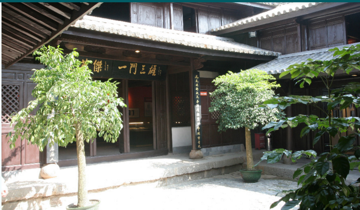
内院西北角立面
