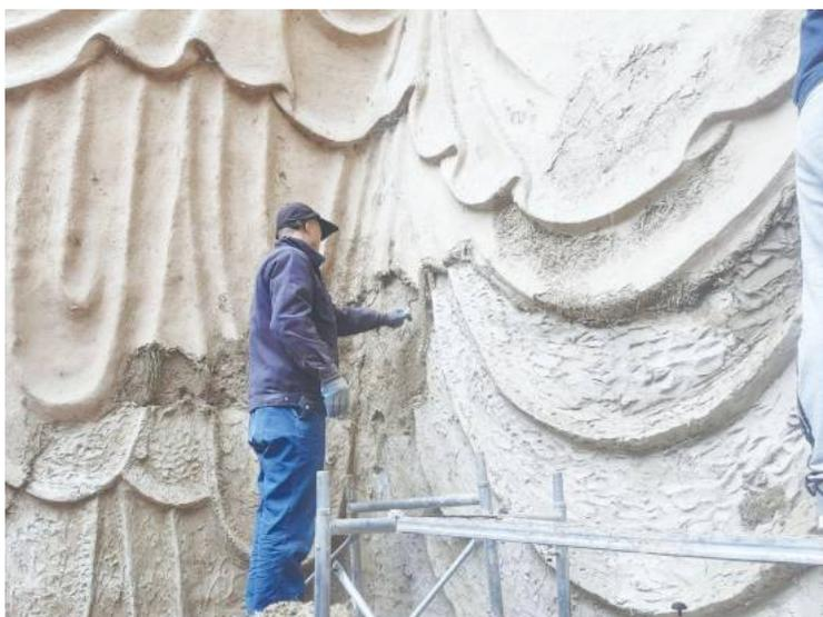
通过这次保护修复工程的实施，可再次恢复天梯山石窟第13窟大佛的整体性和美观性；可防止塑像岩体内部水分和盐分通过泥层纤维毛隙破坏塑像表面泥层；可防止大佛足部、两侧天王足部及龕质补塑部分因受地面渗水而潮湿坍塌。
