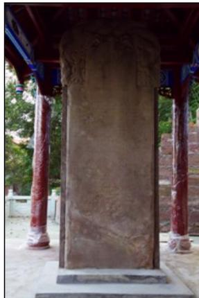
技术人员在工作条件十分简陋的条件下，以严谨、科学、认真负责的工作态度，放弃节假日，全身心地投入工作，经过185天的共同努力，于2011年11月完成了：①赵府君墓碑的粘结加固、锚固、表面修复；②赵府君墓碑与干禄字书碑表面清洗及风化严重部位的封护加固；③赵府君墓碑基础处理；④赵府君墓碑搬迁与安装；⑤赵府君墓碑钢架支护加固；⑥修建赵府君墓碑保护亭和干禄字书碑亭局部维修；⑦保护亭外围修筑排水沟及局部环境整治等7个分项施工及相关分析检测、资料收集整理和修复档案建立工作。通过本项目的实施，使在5·12地震中受到严重破坏已完全断裂破碎的赵府君墓碑能“自立、自稳”，其外观恢复了原貌，达到馆藏文物的陈展要求，同时消除了两通碑体风化剥离的病害根源，使碑体抗风化能力增强，大大延长两通碑的保存寿命。
