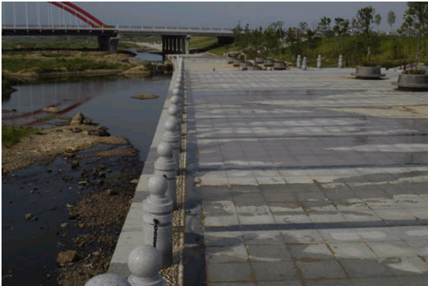
图2 新农村建设名义下的自然河流渠化和“城市化”工程，严重危害自然水系和生态过程 (浙江某地，摄影：俞孔坚)
