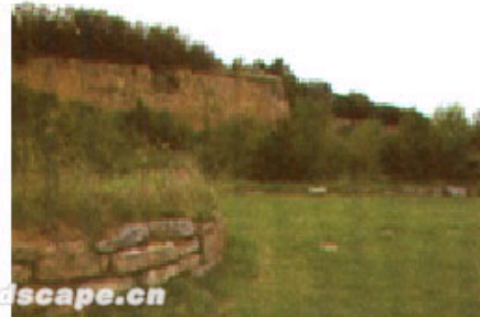
图 22 砖瓦厂公园中用原址上的碎石砌筑的干石墙
