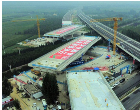
跨沪铁路转体桥完成双转体施工
