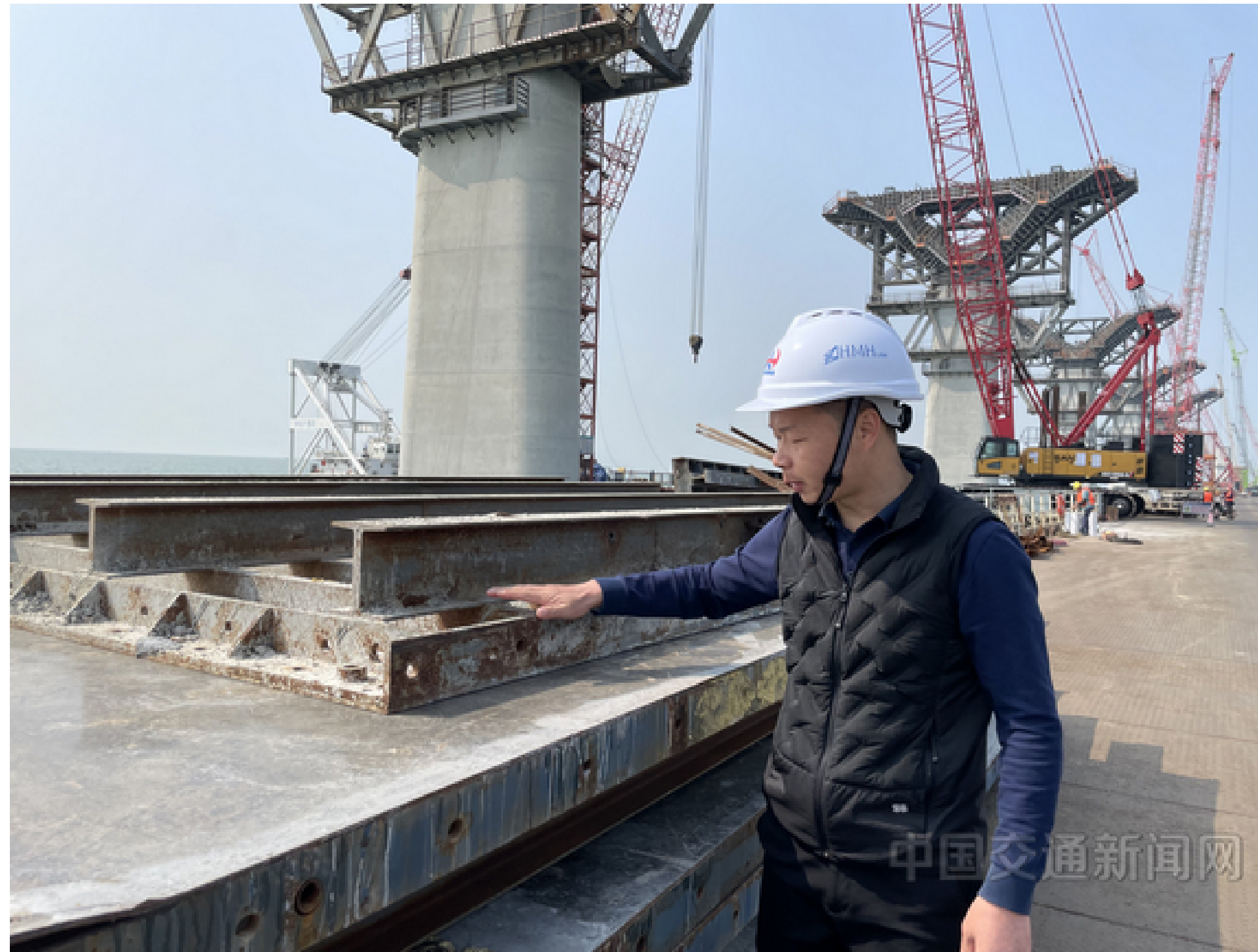
沈大为介绍桥墩混凝土模板拼装情况。
