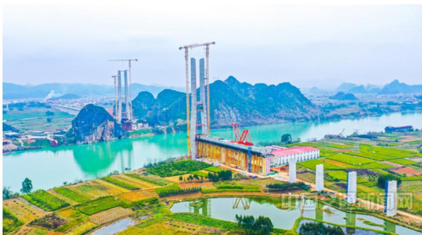
近日，广西壮族自治区南玉铁路控制性工程百合郁江大桥主桥正加紧施工（如图）。该桥主桥设东西两座主塔，塔高146米，桥梁主跨330米，设计时速350公里，为无砟轨道高速铁路大跨径桥梁，目前两岸段各有一个主塔顺利封顶。
