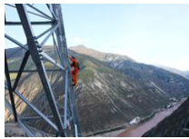
“蜘蛛侠”高原百米高空作业消除电力隐患
